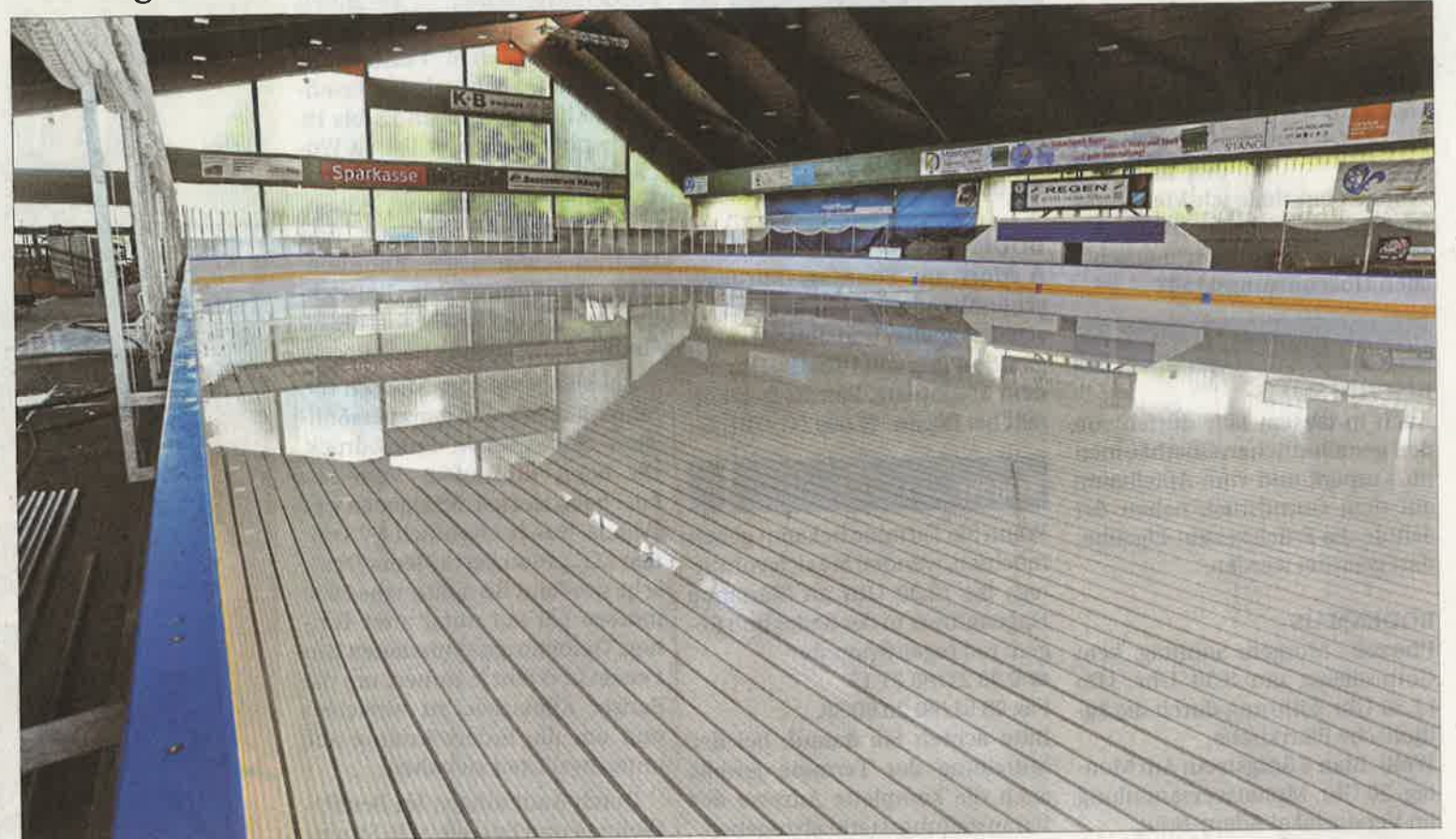
Die erste dünne Eisschicht entsteht gerade im energetisch sanierten Eisstadion in Regen. Die Saison soll am 3. Oktober starten. Die Restarbeiten sollen bis dahin weitgehend erledigt sein. – Fotos: Lukaschik
