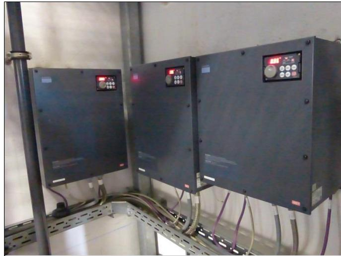
**Frequenzumformer für die Beckenwasserumwälzpumpen**
