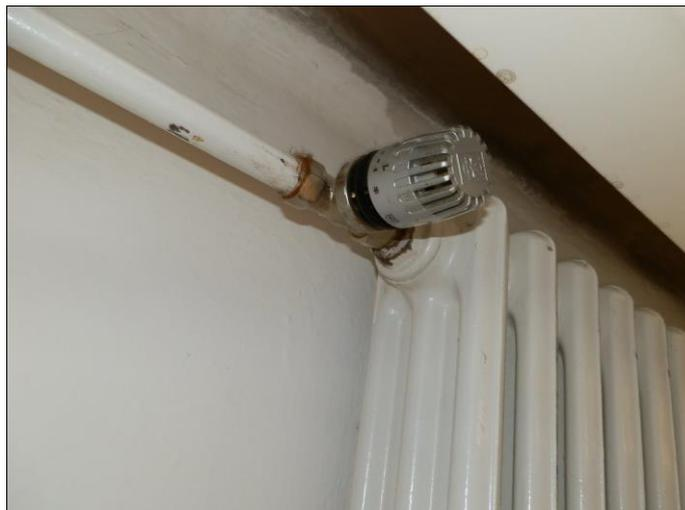
**Heizkörper mit altem Thermostatventil ohne Voreinstellung**
