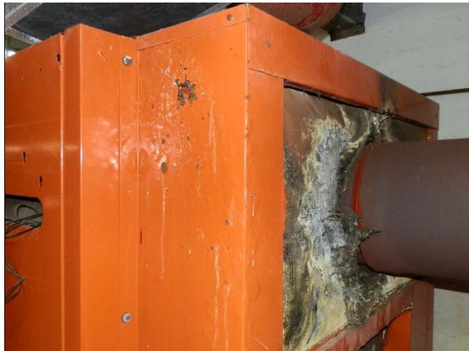
**Freibad/Schäden am Heizkessel**
