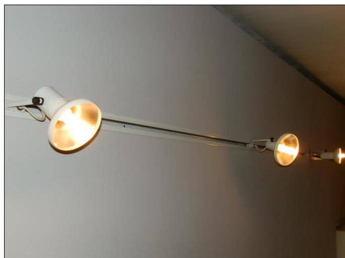
**Strahler mit Kompaktleuchtstofflampen**
