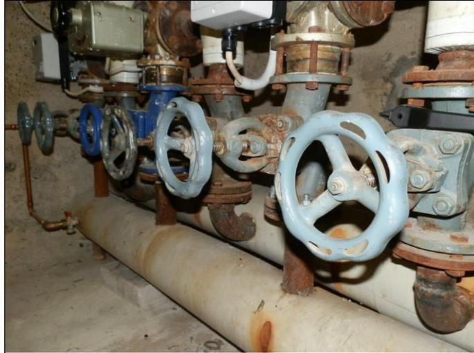
Heizungsverteiler/alte, ungedämmte Absperrventile
