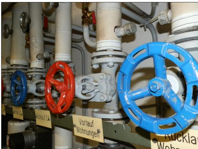
**Alte Absperrventile ohne Dämmung**
