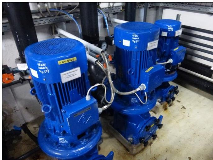
Neue Umwälzpumpen mit stufenloser Drehzahlregelung
