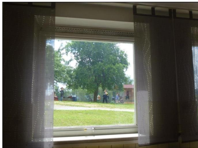
**Alte Doppel-Einfachverglasung im Klassenraum mit Zwangslüftungsgitter**
