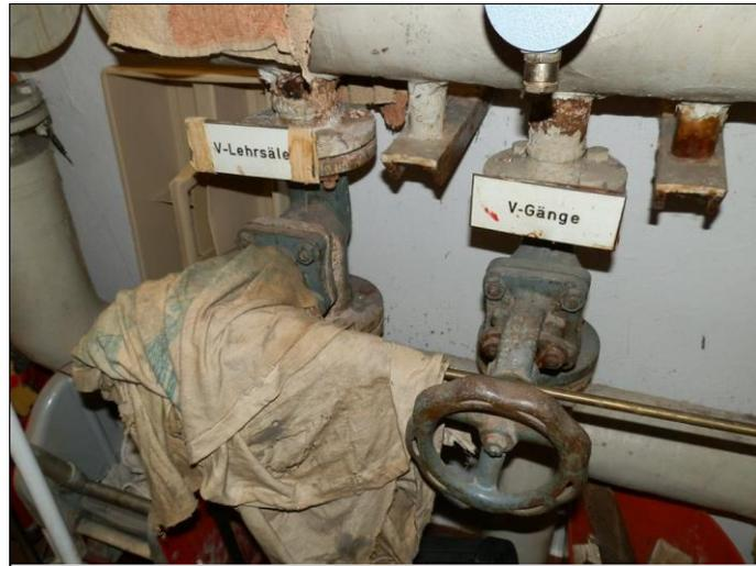
**Veralte Absperrventile ohne Dämmung, alte Verteilung**
