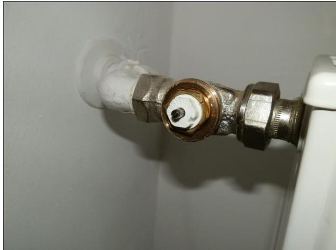
**Heizkörper mit voreinstellbarem Thermostatventil, auf Maximalwert**
