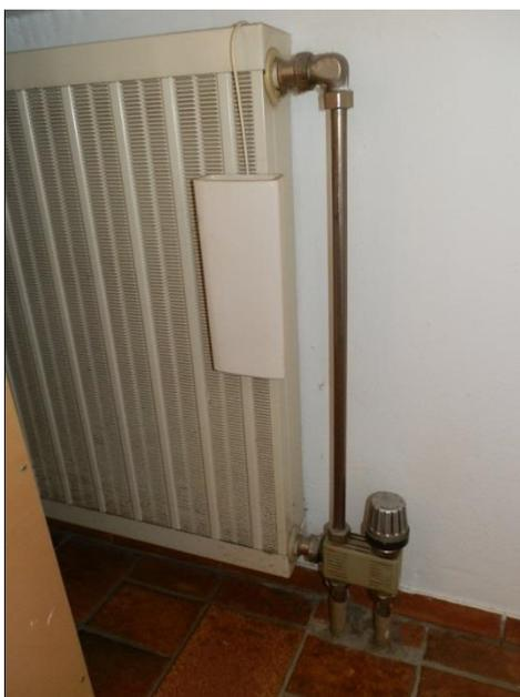
**Einrohrheizung, alter Heizkörper mit Thermostatventil**
